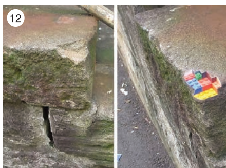
Na levi strani odkrušen okrasni kamen in na desni dopolnjen s 3D-natisnjenim modelom, ki se natančno prilega [6].
