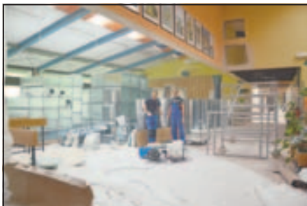
Notranjost šole med izvajanjem del za vgradnjo sistema za prezračevanje, toplozračno ogrevanje in klimatizacijo
