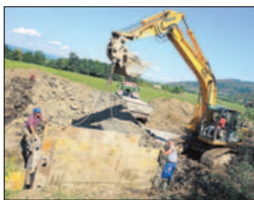
Izkopi na barju zahtevajo posebno tehniko.
