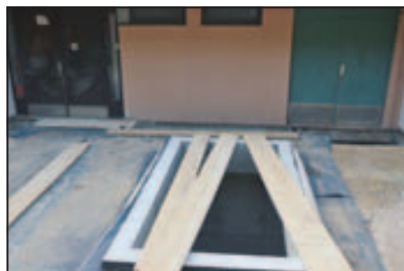
Zalogovnik bo služil za skladiščenje sekancev, na katere se bodo odslej grelji v šoli.
