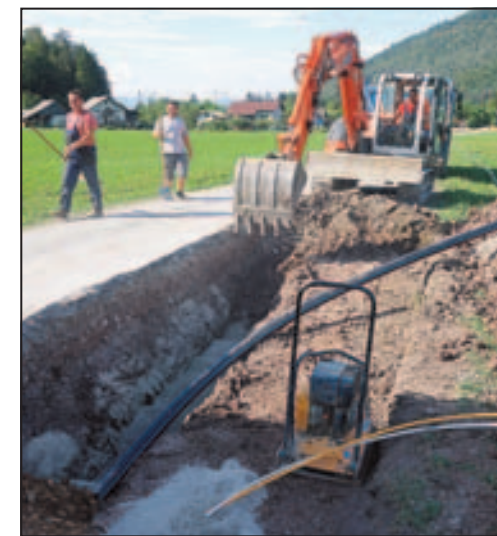
Ob vodovodni cevi se polaga še cev za optični kabel.
