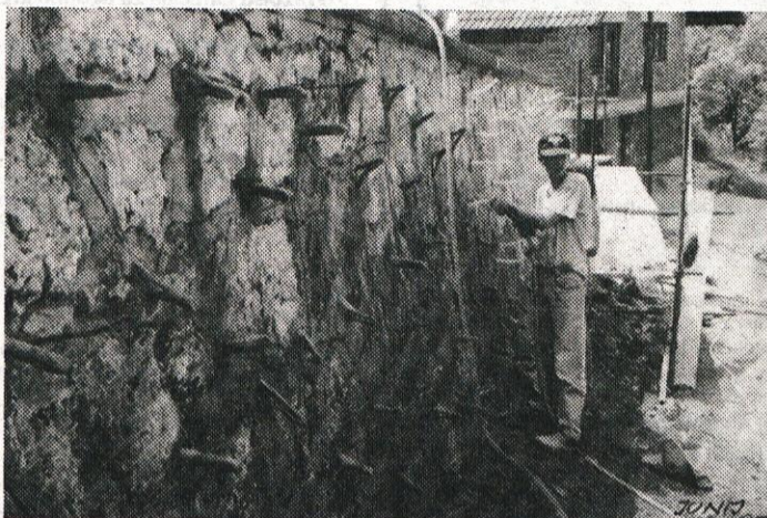
Statično saniranje pokopališkega zidu z injekcijami.
