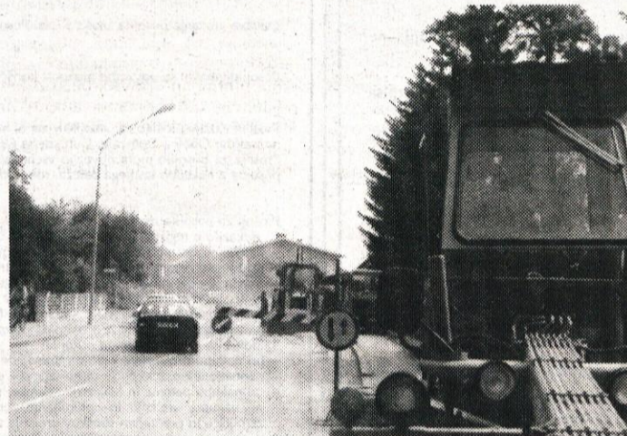
Tu in tam precej razkopana Ljubljanska cesta v Domžalah je bila sredi julija končno popravljena in delno na novo poasfaltirana
