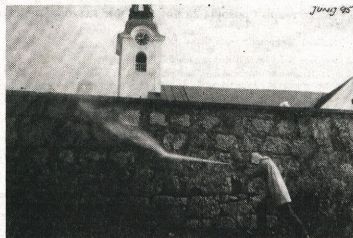
Čiščenje starega pokopališkega zidu z vodnim curkom pod pritiskom.
