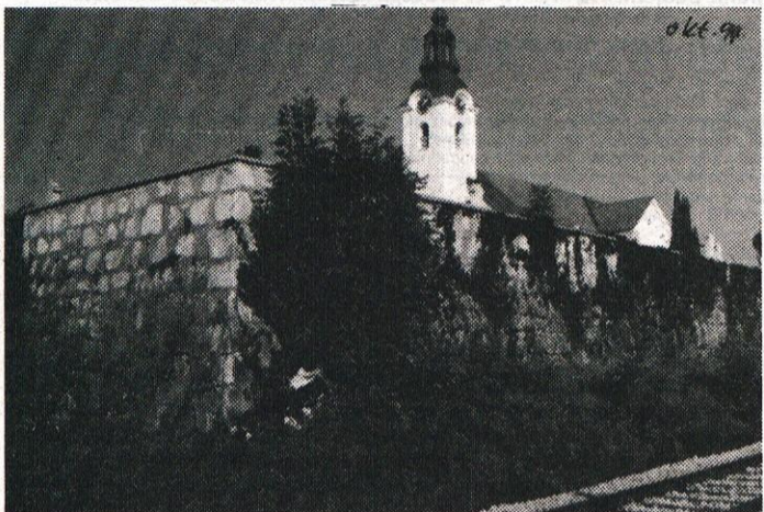
Pokopališki zid pred obnovo
