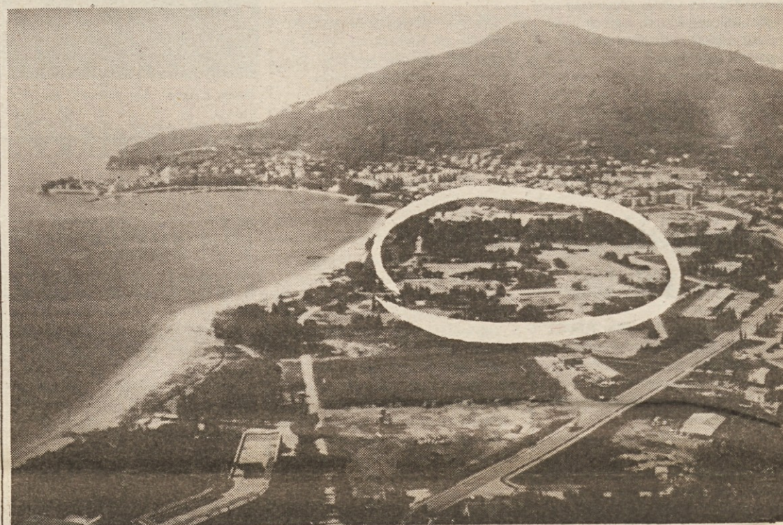
Budva leta 1979 in 1981 — za največjim hotelskim sklopom je ostala le ledina. Hoteli so morali pač počakati na stanovanja, ki so jih doslej zgradili že skoraj 300, živahno pa je tudi na zasebnih gradbenih zemljiščih.
