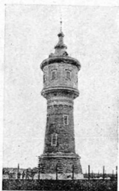
LIBENSKA VODOVODNA STANICA.
