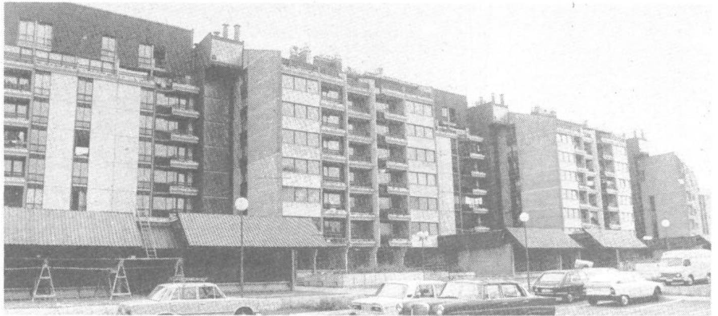
Prvi niz blokov je zgrajen
