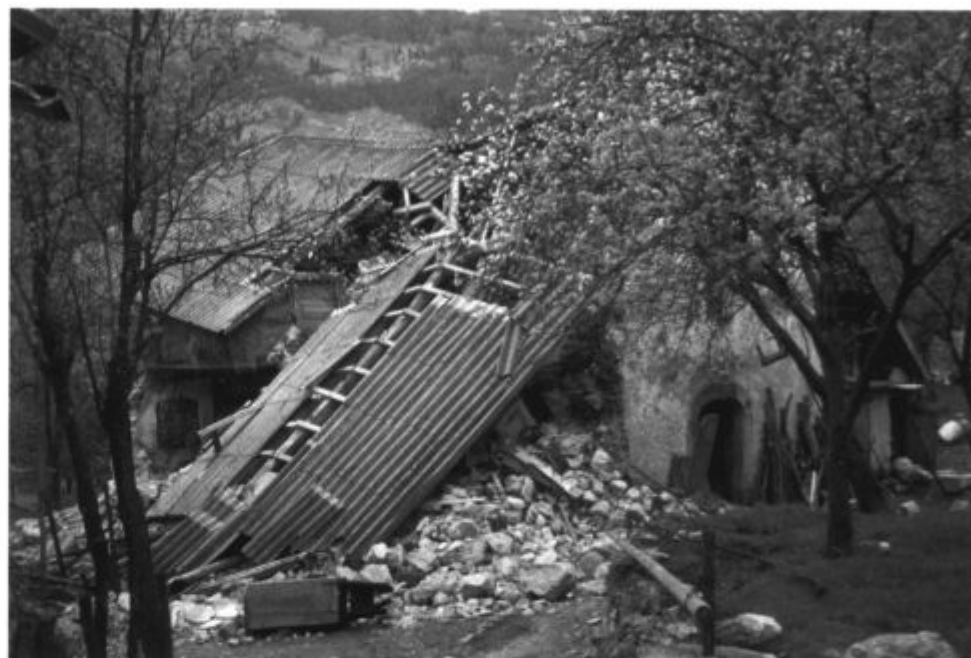
Popolnoma porušeno gospodarsko poslopje na planini Polog nad Tolminom. Poškodba na slabo zgrajenem objektu je bila ocenjena med VIII. in IX. stopnjo po EMS (foto R. Vidrih).
