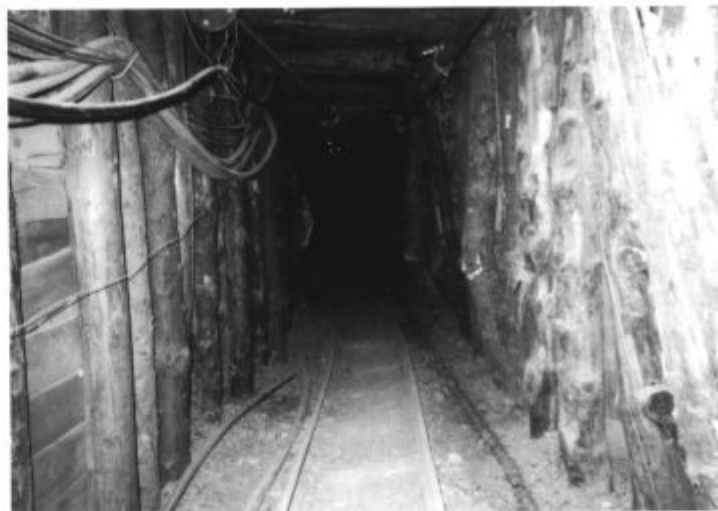
sl. 5: 'Klasičen' idrijski rov. Proga proti slepemu jašku Urban na IV. obzorju. Izdelava, oblika in velikost jamskih rogov so ostale praktično nespremenjene do konca obratovanja jame. Foto: Jože Čar.
