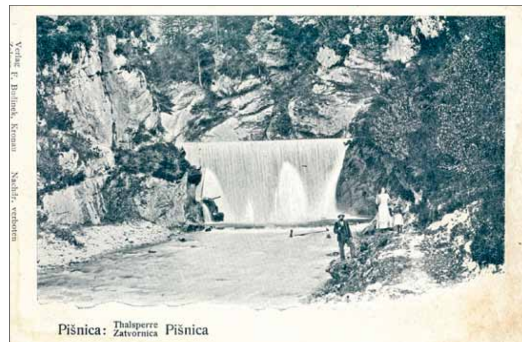
Slika 1: Hudourniška pregrada na hudourniku Pišnica nad Kranjsko Goro – v soteski Babe (založnik F. Budinek iz Kranjske Gore, razglednica izpred leta 1914, avtorjev arhiv).
