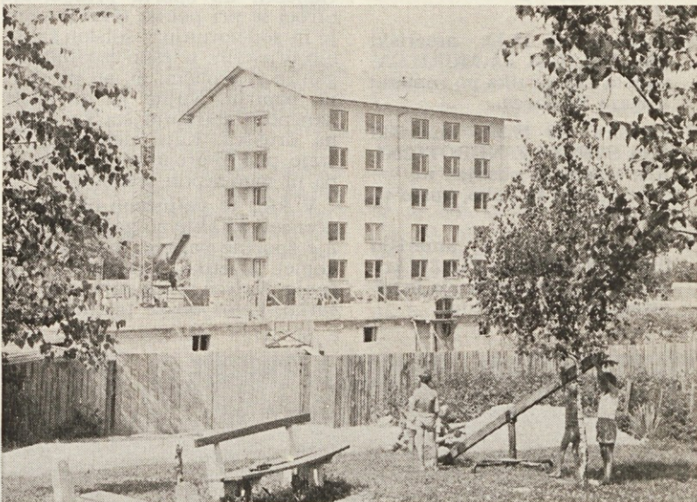
Gradnja tretjega stanovanjskega stolpiča v Vidmu
