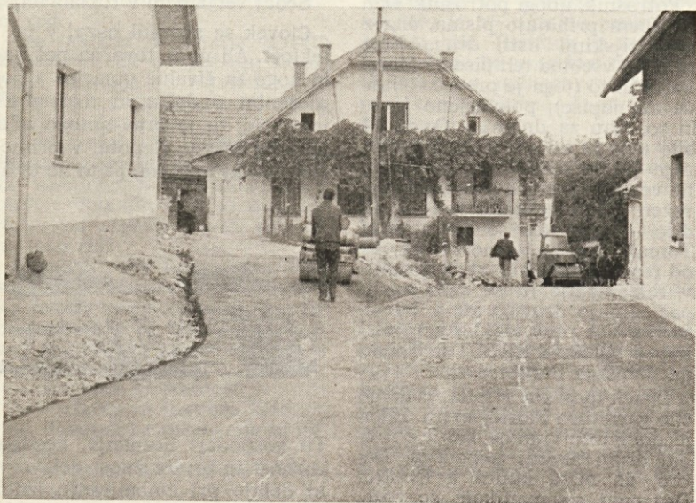
Zaključna asfaltna dela v Gerbičevi ulici
