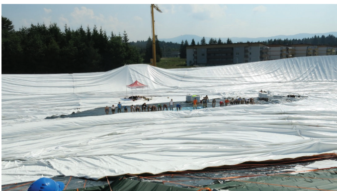
Slika 8 • Velodrom Češča vas, namestitev dvojne napihljive strešne membrane, 23. 8. 2018.
