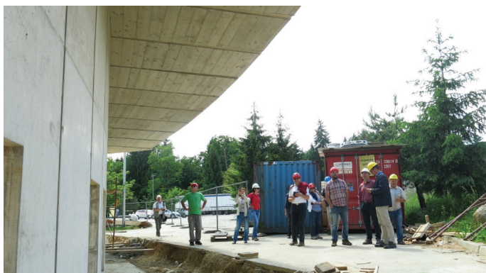
Slika 7 • Oglad gradbišča – rekonstrukcija in dozidava velodroma v Češči vasi, 17. 5. 2018.
