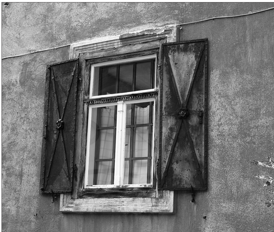
Kovinske naoknice na oknih v Tržiču (foto: Aleš Gabrič).
