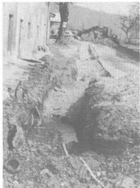
Vse je pripravljeno za gradnjo vodovoda v kraju
