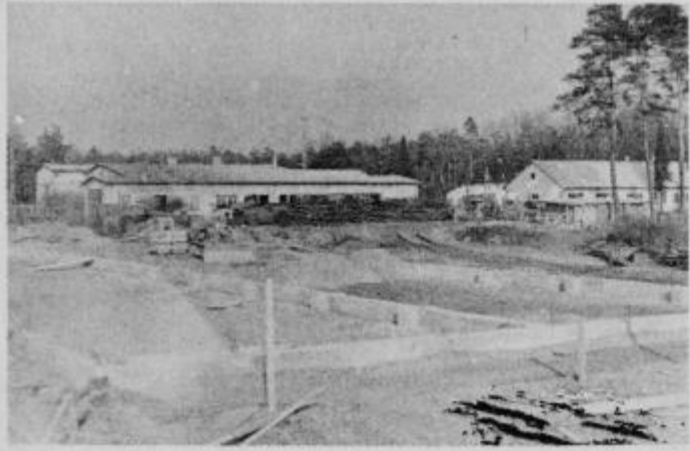
Proizvodna obrt se v naselju vse bolj širi, gradbena dela opravlja »pleskar« iz Ptuja
