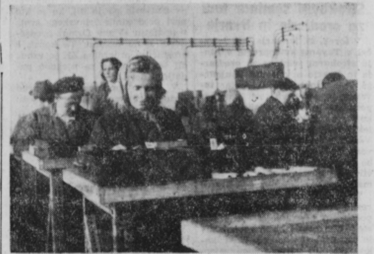
Delo »na liniji« v obratu Avtoopreme v Ptujju
