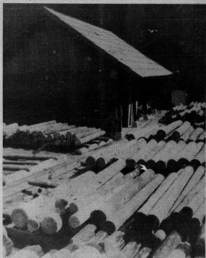
Nekdanja žaga pri Rogovilcu. Slika je iz leta 1938. Takrat je žaga pripadala veleposestvu Marjinegrad in je zaposlovala 8 ljudi. Leta 1944 je pogorela, po vojni pa so jo hitro obnovili. Septembra 1952 je spet postala žrtev plamenov. Sedaj so tam le še ostanki nekdanje lepe žage.
