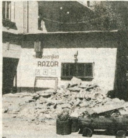
Obnova starega hotela Razor
