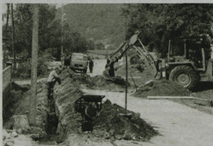
Med polaganjem telefonskega in kableskega omrežja v Krašnji (foto T. Cerar)
