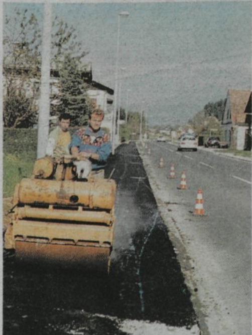
Takole so potekala zaključna dela pri rekonstrukciji in preplastitvi hodnika za pešce ob Kamniški cesti v Preserjah.
