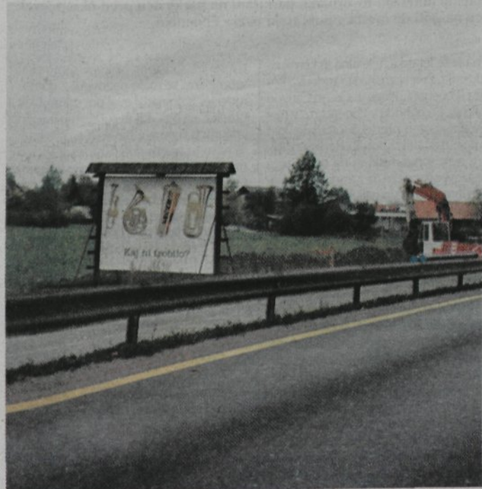
Ob magistralni cesti v starem delu Trzina poteka gradnja vodovodnega omrežja.
