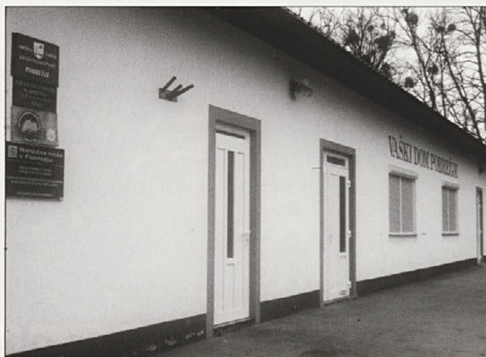
Vaški dom je dobil novo stavbno pohištvo – okna in vrata.
