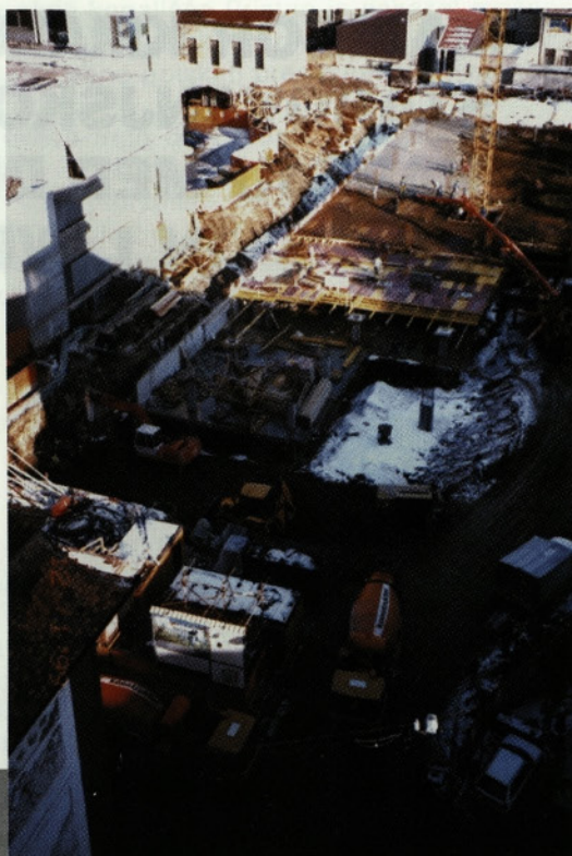
Slika 7: Izvedeno varovanje
