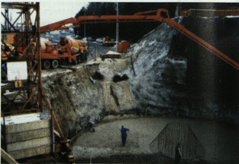
Slika 3: Betoniranje temeljne plošče zadrževalnika
