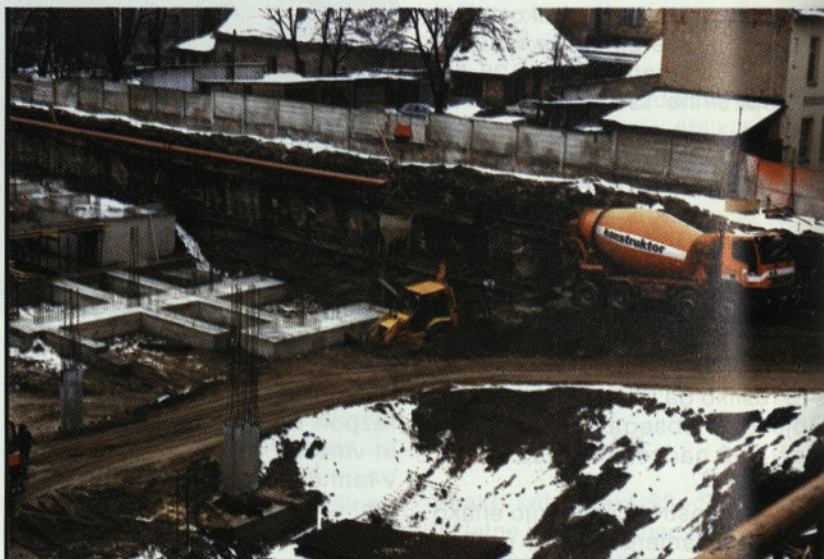
Slika 5: Izvedbe JG slopov - napenjanje sider
