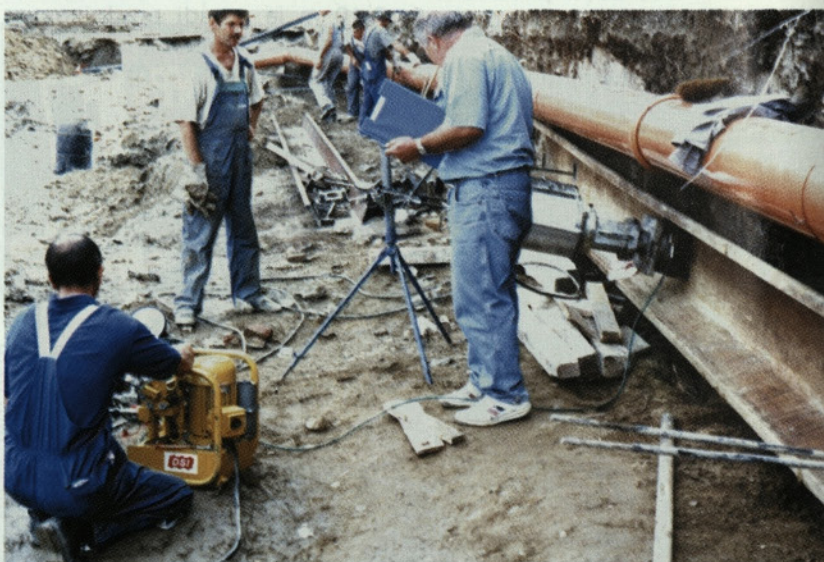
Slika 6: Izvedbe JG slopov - napenjanje sider
