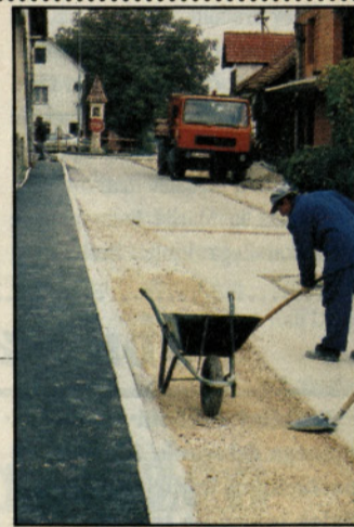
Priprava cestišča ob novem pločniku za preplastitev.
