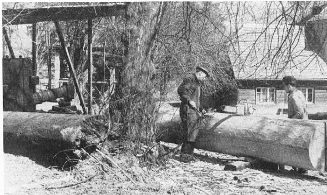
Repač v remontu
