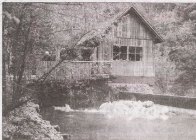
KAMNI V IZVIRNEM JEZERU - Veliko ljudi iz vasi v okolici izvira reke Krupe si je šlo, ko so slišali, da se je začel podirati prvi jez na reki, pogledat, kaj se pravzaprav dogaja. Mnogi so si oddahnili, ko so videli, da jez še vedno stoji. Ni pa bilo mogoče spregledati kupa debelih kamnov, ki jih je lastnik mlina in žage Matjaž Puš navozil za jez in s katerimi je, kot je sam zatrnil, zamašil luknjo v jezju. (Foto: M. B.-J.)
