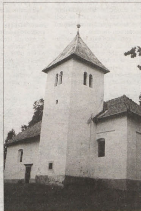
PROPADANJE - Cerkev sv. Lovrenca na Smuku čaka na prepotrebno obnovo.
