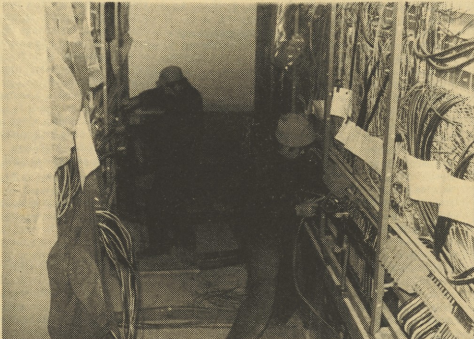
Elektromonterji urejajo in priključujejo kable v N. N. razdelilno ploščo.
