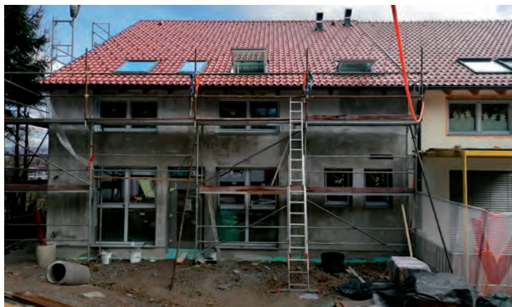
Izvajanje fasadnih del na prizidku
