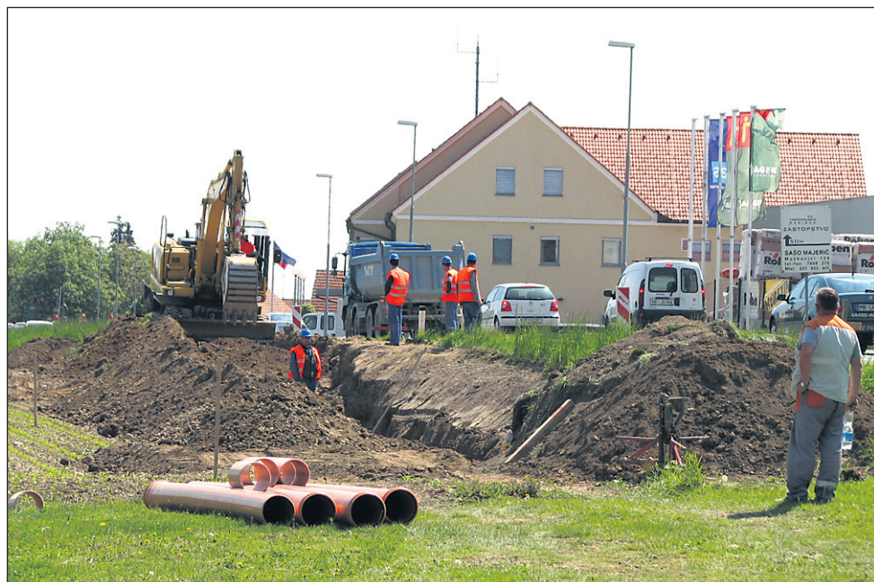
Foto: SM Vrtca zaradi zamujanja vlade v Gorišnici še ne gradijo, zato pa so v polnem teku dela pri izgradnji celovitega kanalizacijskega sistema.
