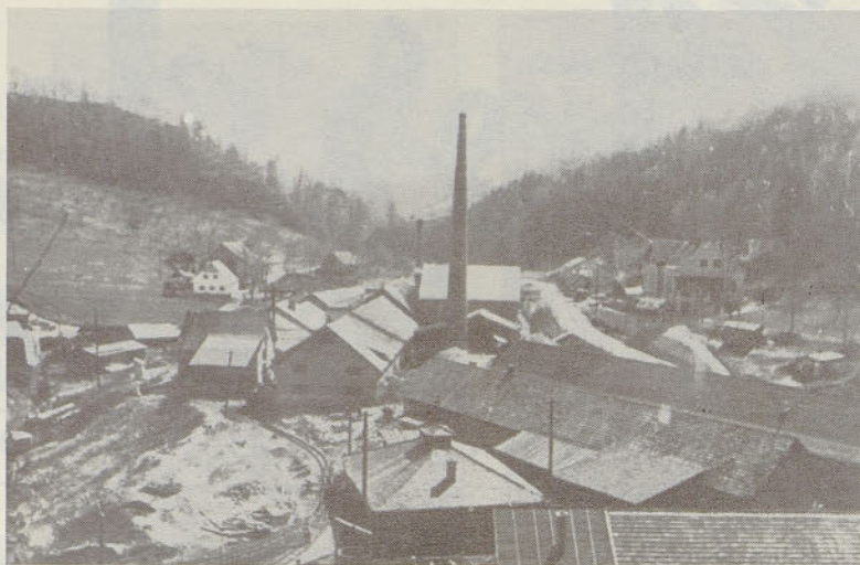
Priprave na gradnjo plavža 1952. leta
