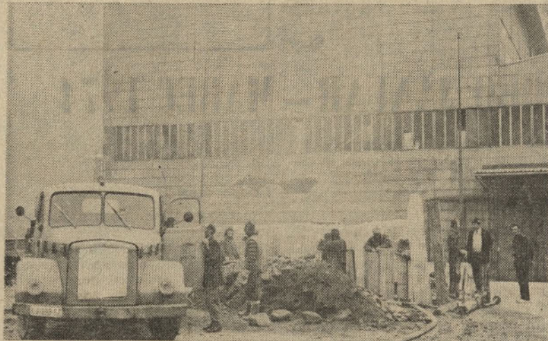
Začetek gradnje podaljška hale za proizvodnjo kelihov. Že obstoječi objekt se podaljša za 25 metrov
