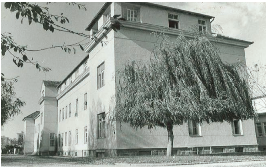
Slika 2. Zasilni prostori v pritličju vzhodnega dela starega internega oddelka l. 1919 – Arhiv UKC Maribor – danes stoji na isti lokaciji od l. 2017 nov Oddelek za očne bolezni
