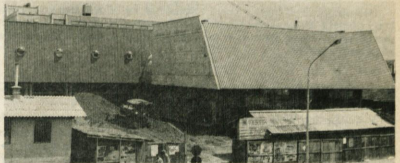
Veleblagovnica v izgradnji
