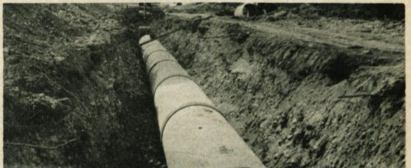
Zaključna dela na kolektorju proti Studu
