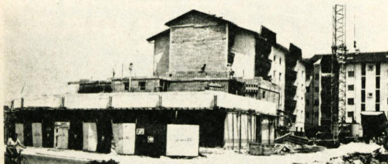
Stanovanjsko-poslovni objekt v izgradnji v Mengšu
