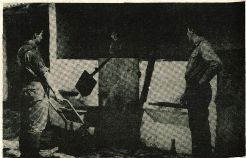
Čprav niso gradbeniki po poklicu, bodo sami postavili škarpo.
