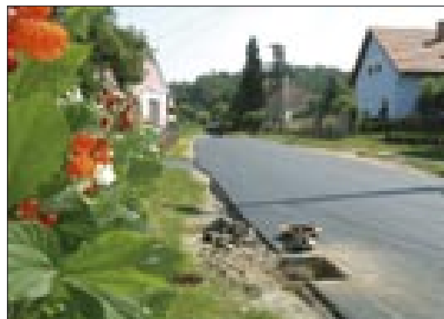
Del obnovljene glavne ceste v Sakalovcih
