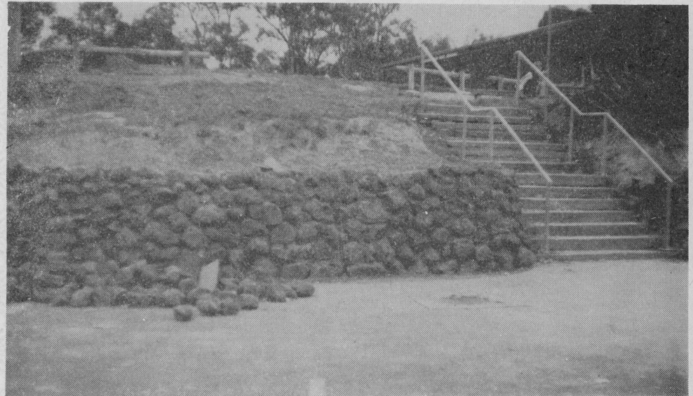
Pod otroškimi igriščem dokončujejo kamenito škarpo ki bo ščitila parkirane avtomobile.
