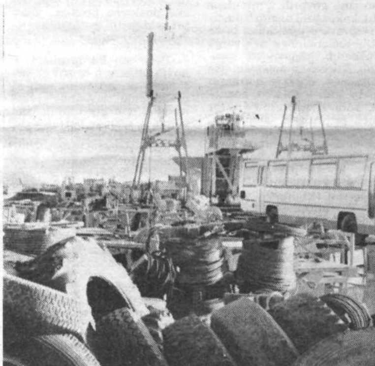
Na obsežne skladiščne površine pri Abu Ghraibu pri Bagdadu dostavljajo z gradbišč SCT v Iraku gradbene stroje, silose, strojno opremo, opaže, vozila in druge materiale, ki jih bodo rabili za postavljanje novih projektov v tej arabski državi.
