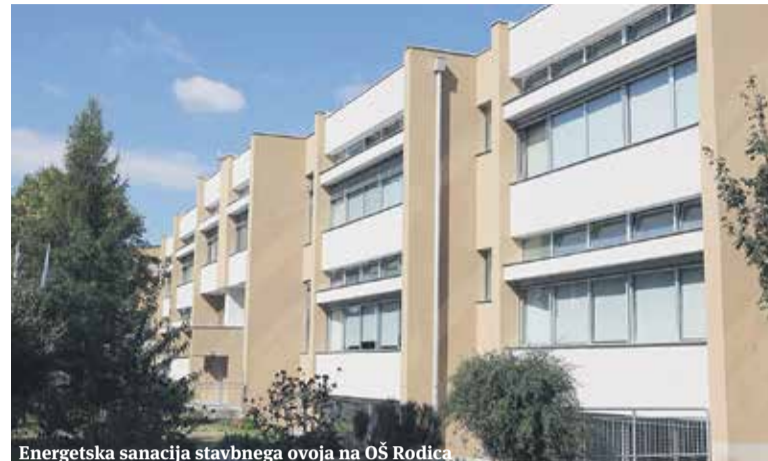
Energetska sanacija stavbnega ovoja na OŠ Rodica
