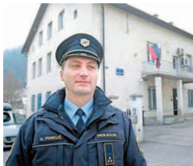
Stavba policijske postaje je nujno potrebna vzdrževalnih del. / FOTO: GORAZD KAVČIČ
