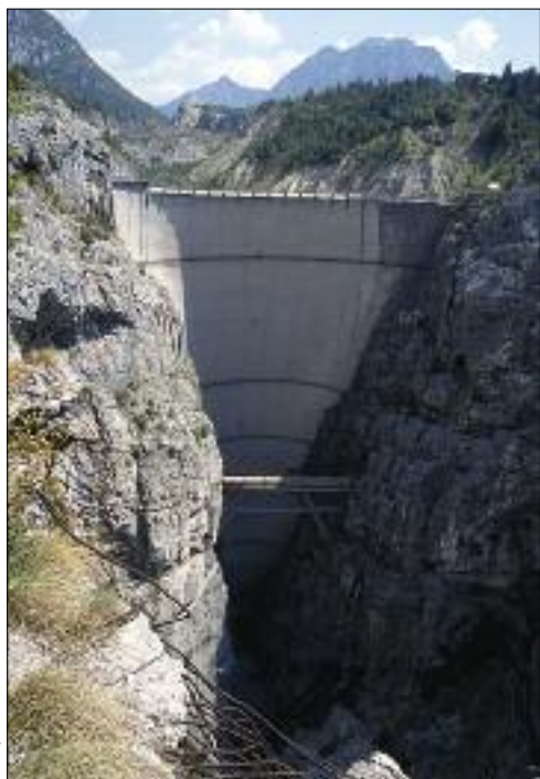
Slika 12: Pregrada v dolini Vajont. Za pregrado je vidna odložena gmota kamnitega zdrs, poraščena z drevjem.
