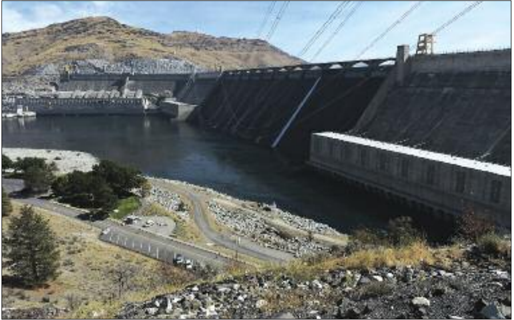
Slika 9: Jez Grand Coulee na reki Columbia v ameriški zvezni državi Washington so gradili med letoma 1933 in 1942. Jez je visok 168 m in dolg 1592 m.
