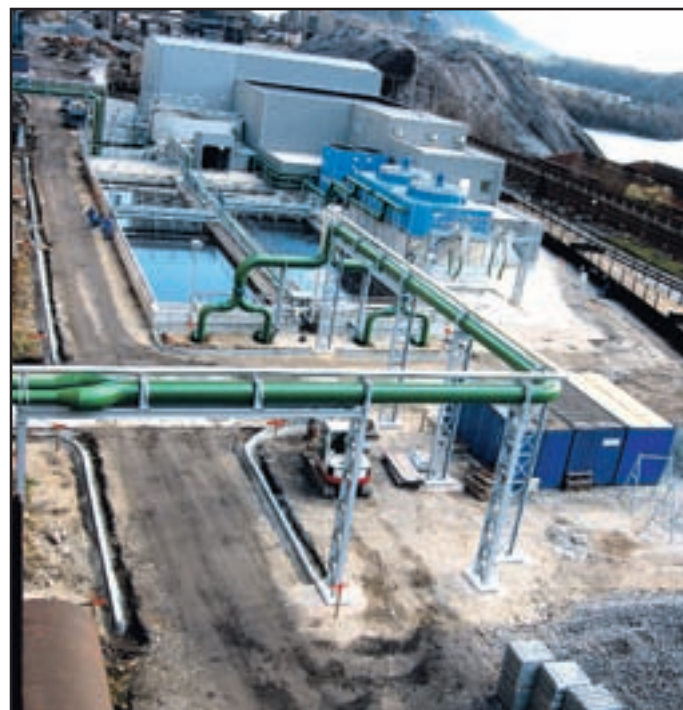
Čistilna naprava za »škajni« jami valjarskih ogrodiv z obdelavo muljev v jeseniškem Aconiju.
