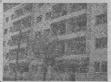
SARAJEVO: do leta 1954 je dobilo Sarajevo 4310 stanovanj ali 291 stanovanj na 10.000 prebivalcev. Največ stanovanj so zgradili leta 1951.
