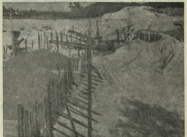
Savski prod v številnih širokih terasah predstavlja pomembno gradivo za gradnjo naših cest. Vendar pa delo z buldozerjem lahko občutno poslabša kvaliteto proda, ker se pri tem zdrobijo mehki prodniki v prah, ki je v betonu škodljiv. Na sliki je gramoznica Drnovo pri Krškem
