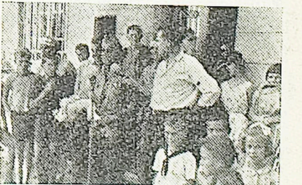
Prisrčen sprejem mladih brigadirjev po vrnitvi s ceste v Postojni. Pred železniško postajo se je Postojničanom zahvalil komandant brigade Trampuž in obljubil, da bodo brigadirji nadaljevali delo na cesti tudi prihodnje leto
