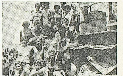
Buldožerji so bili mladim brigadirjem na cesti v veliko pomoč. Na sploh pa je bilo cesto mogoče zgraditi v določenem roku samo zaradi izdatne mehanizacije
