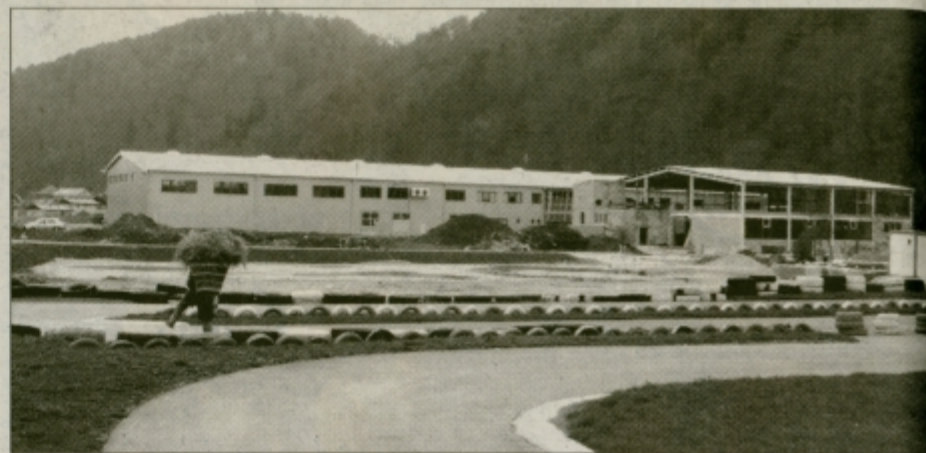
Obrtna cona Štore-vzhod, pri lokalu Cibi. Najprej je bil zgrajen veliki objekt laškega podjetja Eho, trenutno gradi še šentjurski Fast. Letos bosta začela z gradnjama podjetji Pilih ter Etiks.
