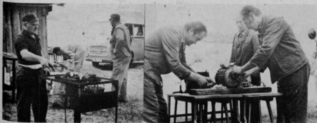
Improvizirana kovačnica in popravilo elektromotorja
