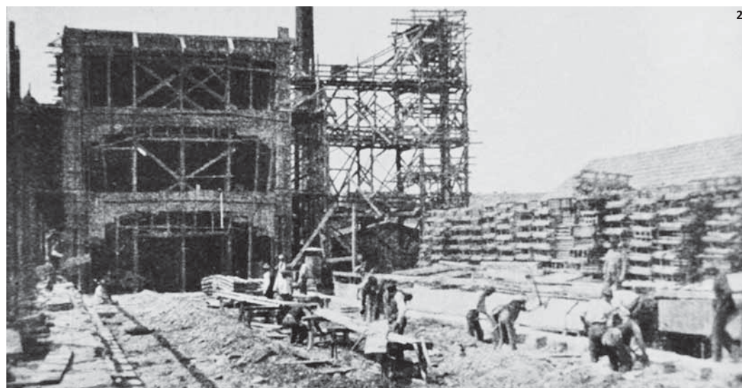
Sl. 2: Gradnja tovarniškega poslopja, 1922. Vir: Beton u. Eisen, Berlin, 1927, str. 178.
