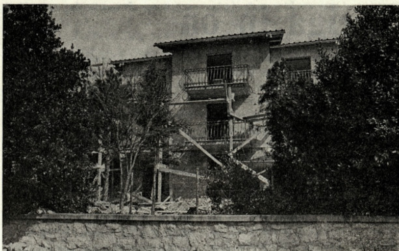
Nova zgradba počitniškega doma v zaključni fazi gradnje
