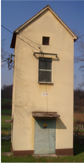
Transformator v Radomerju, zgrajen leta 1943
