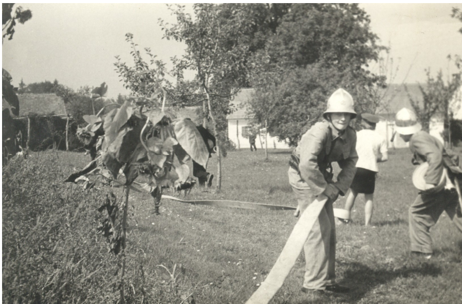
... in polaganje tlačnega voda
