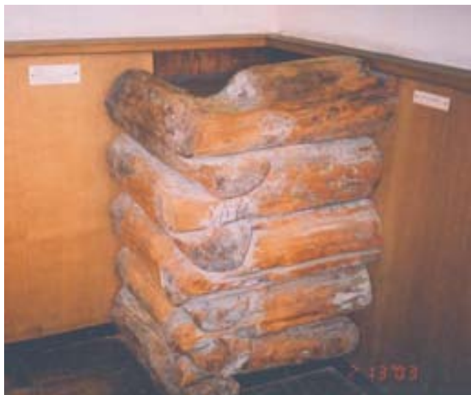
Slika 2: Del vogalne konstrukcije kladne stene iz halštatske dobe v muzeju na Dunaju (foto: J. Kušar). Part of the corner structure of the log wall built during the Halstat period from the Vienna Museum.
