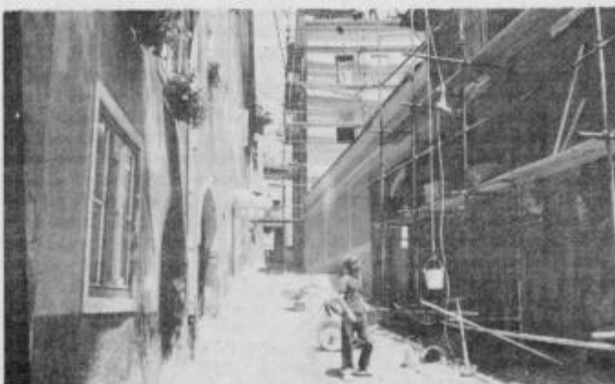
Obnovitvena dela na Slovenskem trgu 3
