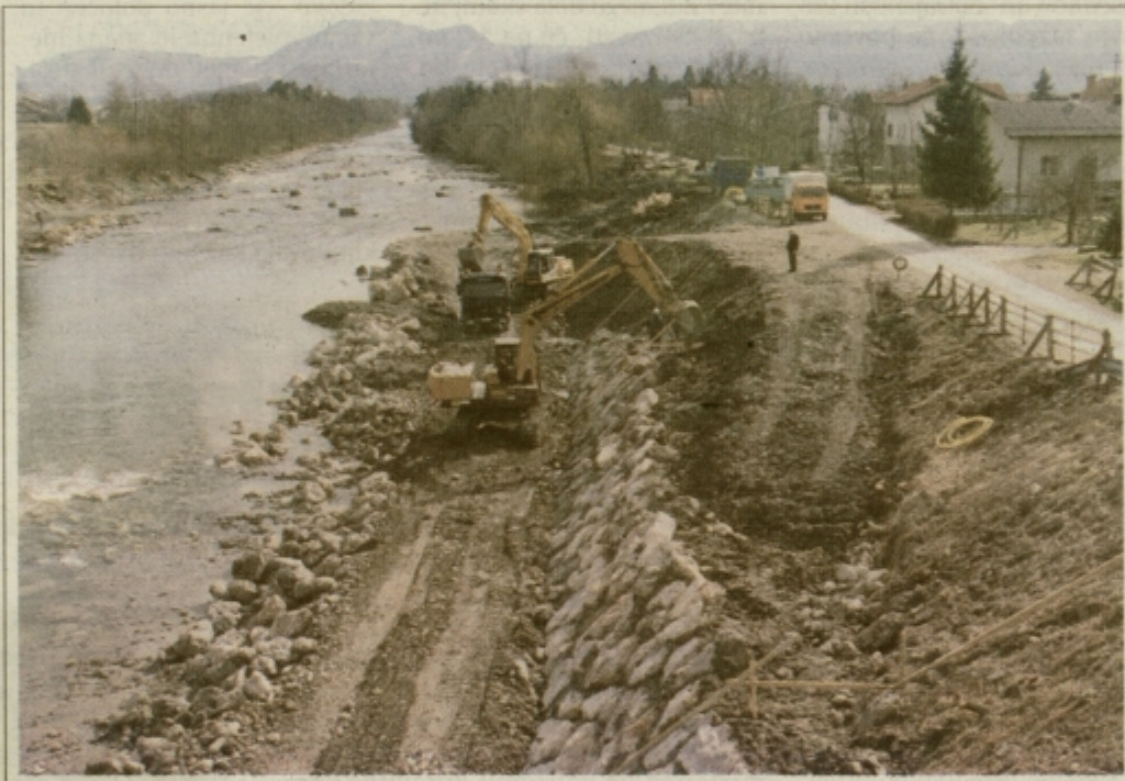
Gradnja škarpe na desnem bregu Savinje na Polzeli.
