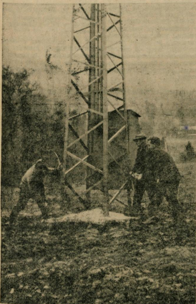
Na sliki: Požrtvovalnemu električarju Tinetu sta priskočila na pomoč Lovro Hočevar in Jernej Korošec. Na drogu je montiran transformator, ki bo odslej napajal z električno energijo vasi okrog Hruševke.
