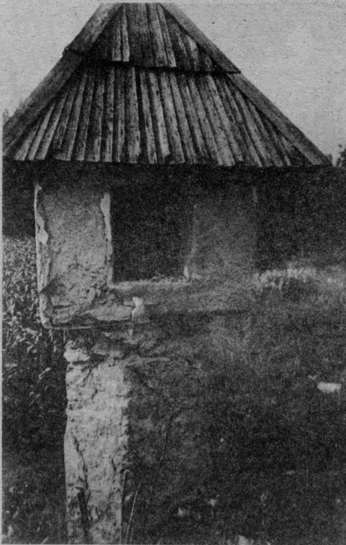
Poškodovano kužno znamenje v Ljubiji
